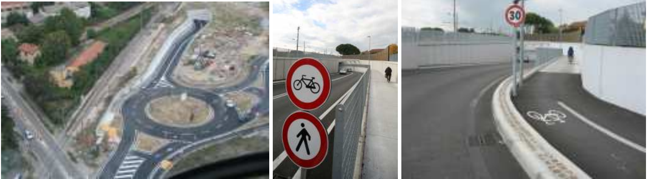
sottovia di collegamento
