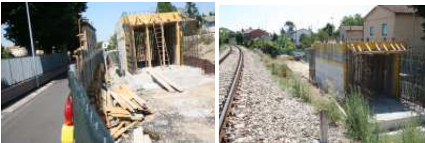
lavori per il sottopasso
