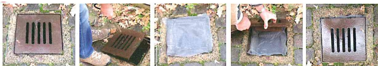
Illustrazione 1: Come posizionare la zanzariera in un tombino/pozzetto
